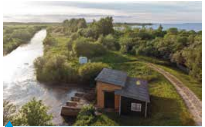
Tamm hoiab ära vee valgumise kuivendatud alale. Esiplaani on pumbajaam, mis pumpab vett poldri kuivenduskanalist välja. Piki tammi läheb tee. Taamal paistab Peipsi järv. Räpina polder.
