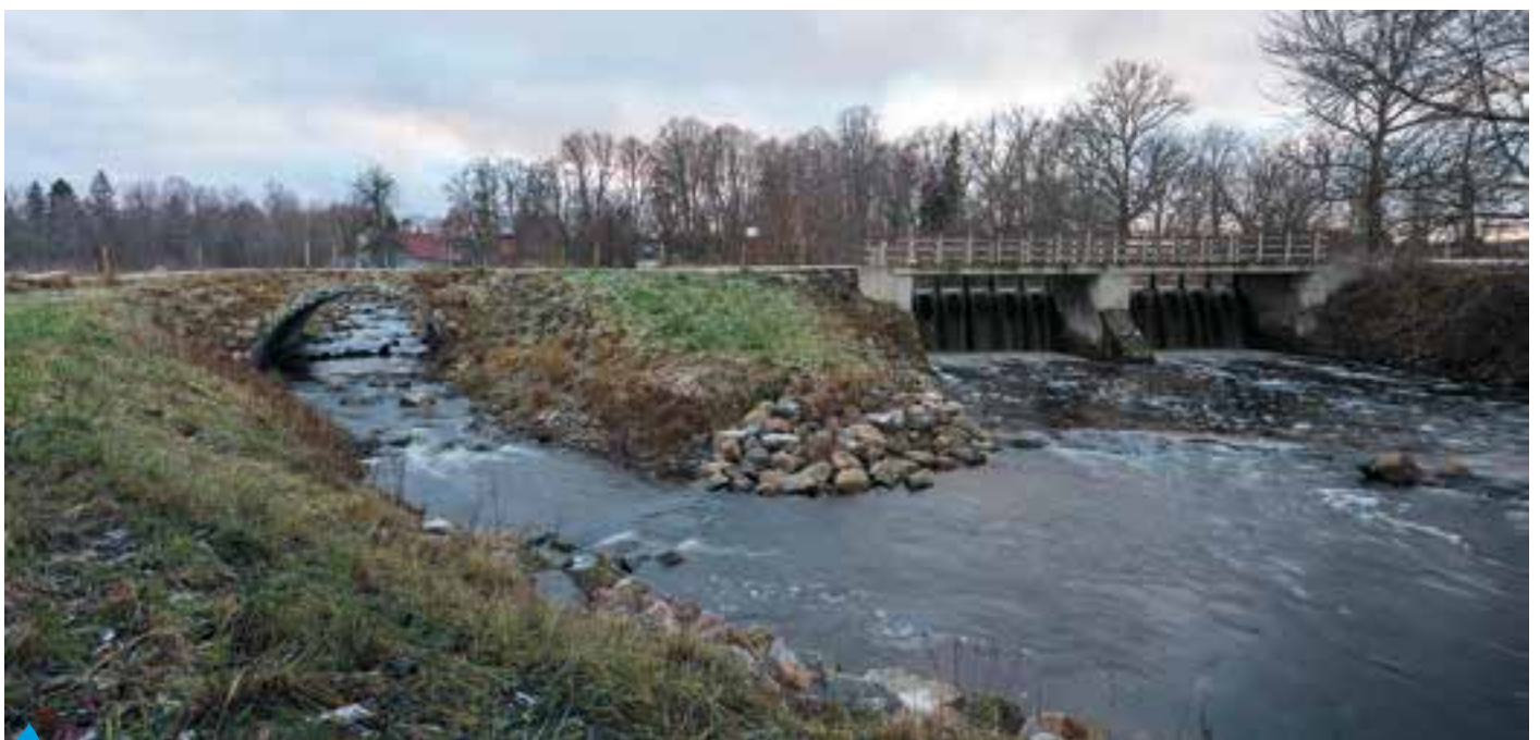
Euroopa Liidu toel ehitati Loobu jõel asuva paisu kõrvale kaasaegne kärestikuline kalapääs.
